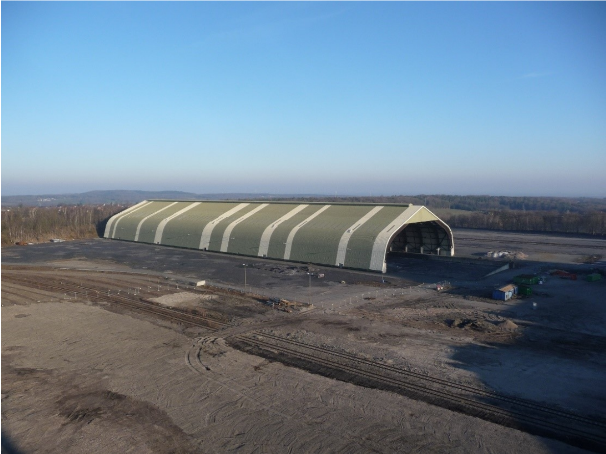
Das gründlich freigeräumte Gelände mit freiem Blick nach Mettingen bis nach Bramsche, Foto: RAG
