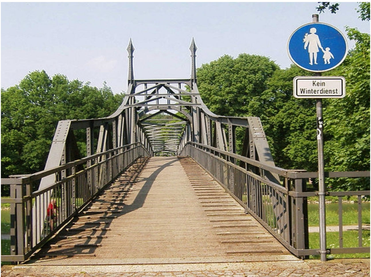
Der „Bevergerner Steg“ ist eine Fußgängerbrücke mit aufwendiger Eisenkonstruktion. Sie führt über die sogenannte „Neue Fahrt“ des Dortmund-Ems-Kanals und wurde im Jahr 1914 freigegeben. Foto: Stadt Hörstel.
